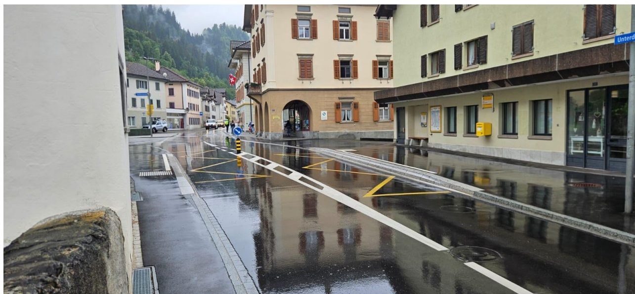
Sanierung Bushaltestelle Dorf gemäss Behindertengleichstellungsgesetz
